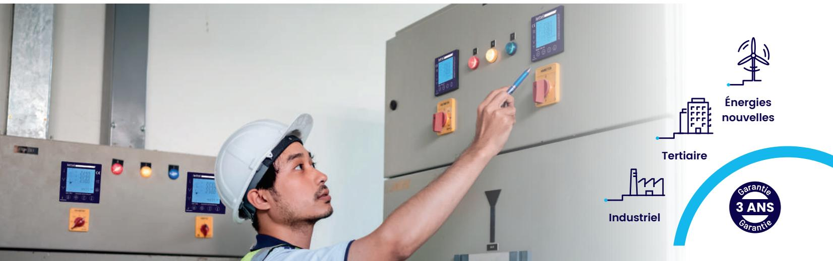
Disponibles au format 72x72 ou 96x96mm, les centrales de mesure MAE doivent être associées à des transformateurs de courant à sortie 1/5A ou à des boucles Rogowski.
